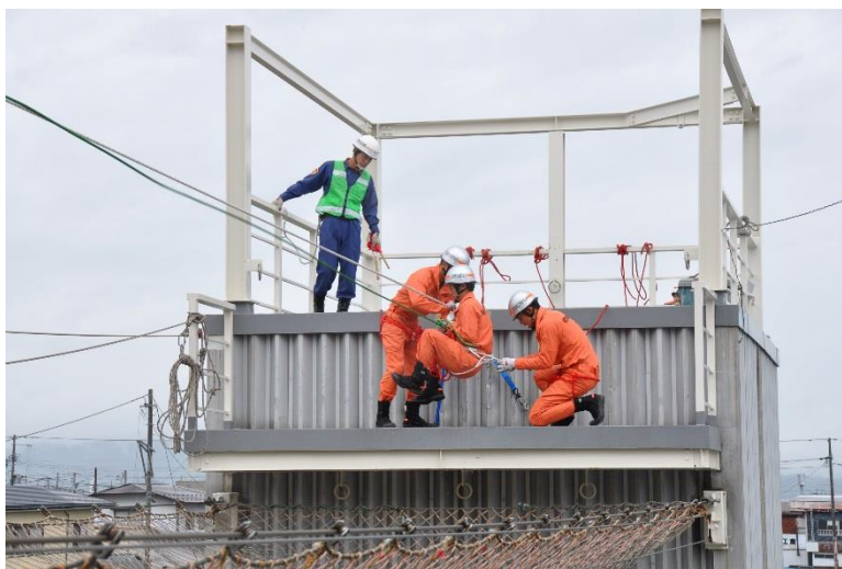
ロープブリッジ救出訓練
