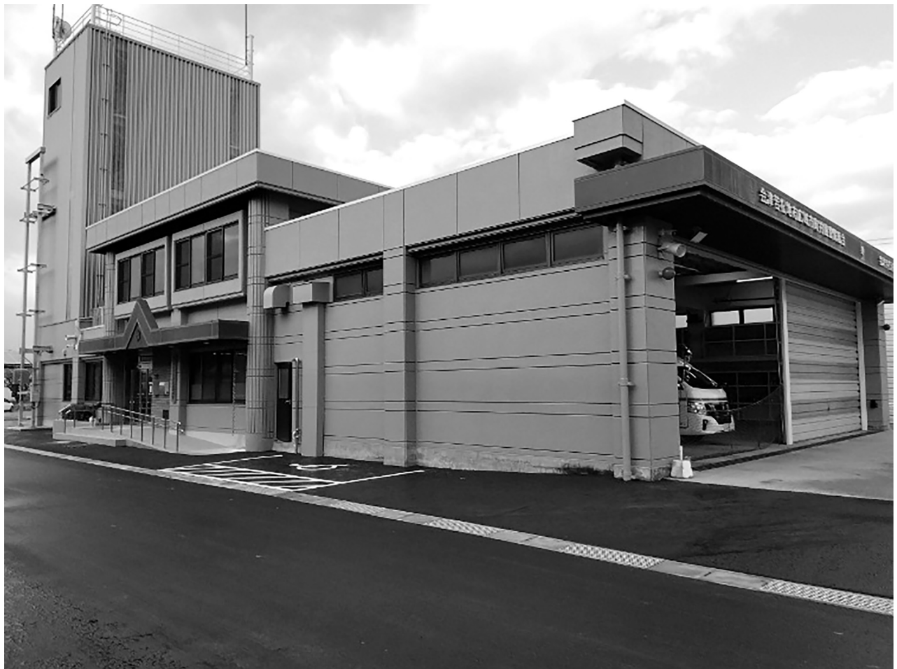
【会津若松消防署城南分署竣工（令和7年10月 大規模改修工事完了）】
